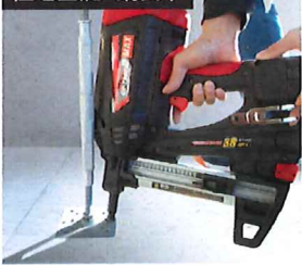
住宅基礎:鋼製束
